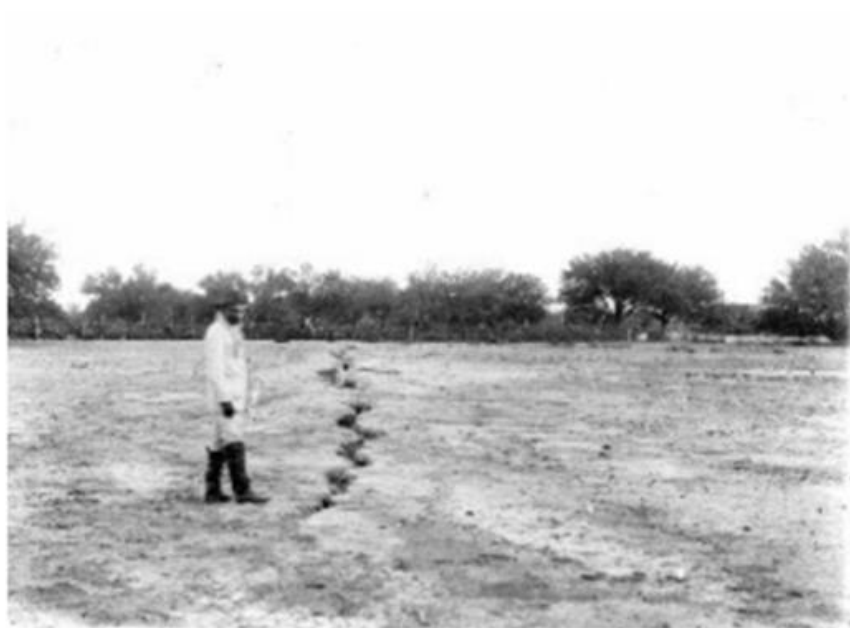
Fig. 2. Grieta en Mogna. Terremoto de 1894.
